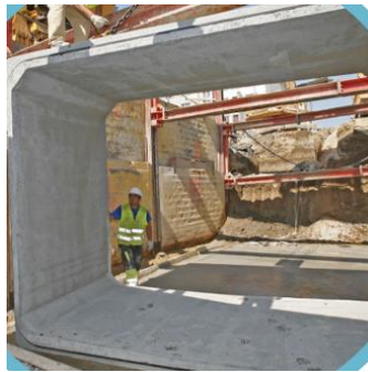
Lutter contre les pollutions et stocker les eaux superficielles
