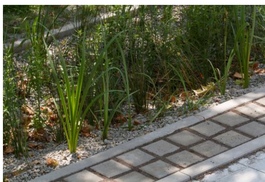
Aménagement urbain : embellissement et préservation de l'infiltration des eaux pluviales in situ
