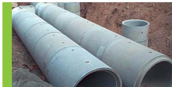
*Stockage des eaux dans des canalisations en béton de grandes dimensions*
