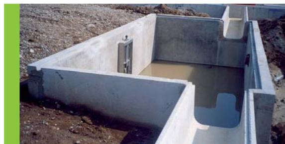
*Bassin de rétention en éléments préfabriqués en béton assemblés sur site*
