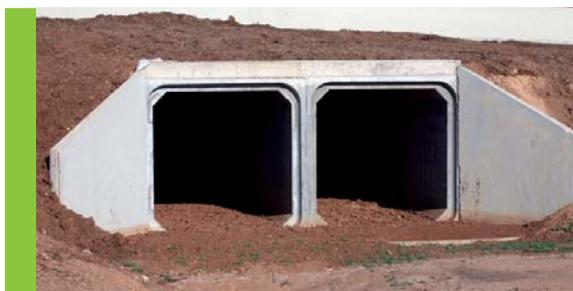
*Cadre double en béton sous chaussée*
