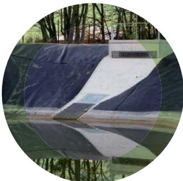
Les ouvrages de régulation sont situés quant à eux à l'aval du bassin. Ils permettent de réguler, notamment lors d'un événement pluvieux important, le débit de restitution des eaux vers l'exutoire, d'évacuer le trop plein du bassin si nécessaire et d'assurer la fermeture du bassin d'orage en cas de pollution importante ou accidentelle. Ils sont équipés d'une lame siphonoïde pour retenir les hydrocarbures en surface.
