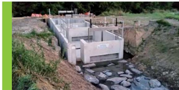
Ces dispositifs doivent permettre le passage et ouvrir la voie d'eau pour différents types de poissons dans les meilleures conditions possibles en fonction de leurs capacités de nage. Ils sont donc adaptés aux caractéristiques et au comportement de chaque espèce migratrice et au site. Chaque passe à poissons est donc conçue sur mesure.
